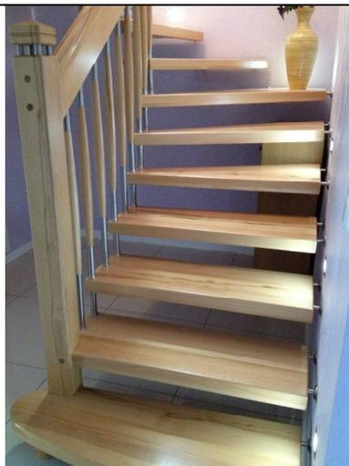
Eine freitragende Bolzentreppe benötigt keine Stahlkonstruktionen als Unterbau. Sie besteht einzig aus Trittstufen, Treppenbolzen und Wandankern. Die Stufen einer Bolzentreppe werden mit gummigelagerten Bolzen direkt im Mauerwerk befestigt. Zwischen den einzelnen Treppenstufen befinden sich einzelne Tragbolzen aus Metall oder Holz, das heißt, dass keine zusätzlichen Wangen wie bei anderen Treppen benötigt werden.
